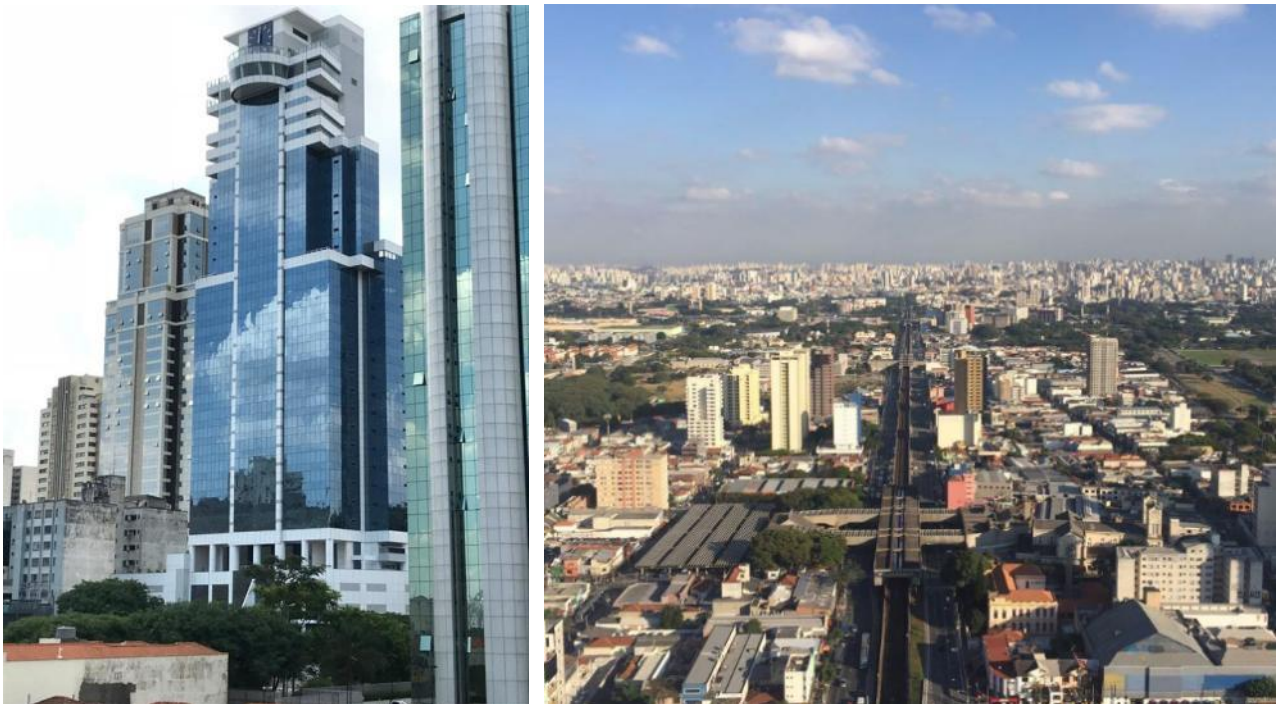
Figuras 40 e 41: NOVAS TORRES CORPORATIVAS NO DISTRITO DE SANTANA E VISTA A PARTIR DELAS. Fonte: https://www.znimoel.com.br
