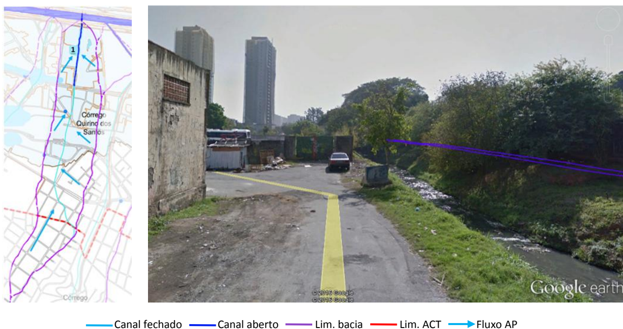
Figura 6.18.1. Localização Bacia, Córrego Quirino dos Santos, áreas de inundação, trecho em canal natural entre Av. Marques de São Vicente e Marginal Tietê. Fonte: Google Earth, acesso 29 jan 2016.
