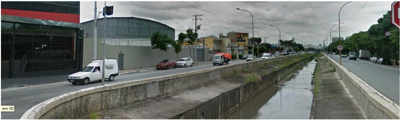
Figura 6.1.2. Situação atual do Córrego da Divisa. Fonte: Google Earth. Acesso 06 fev 2019.
