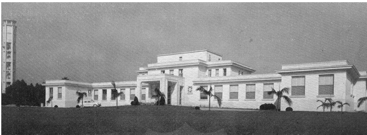
Figura 6 – Vista do Ambulatório (a partir da pista), projetado por Henri Sajous, 1955.
